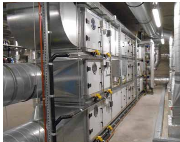
Foto 1. Een luchtbehandelingskast boven het brandwondencentrum
